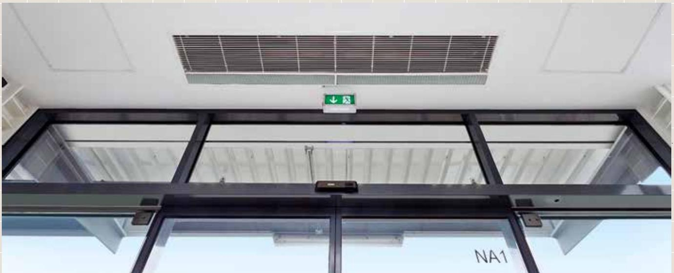
Die Türluftschleieranlage im Eingangsbereich sorgt dafür, dass ein energieintensiver Luftaustausch zwischen Außen- und Innenbereich nachhaltig verhindert wird.
