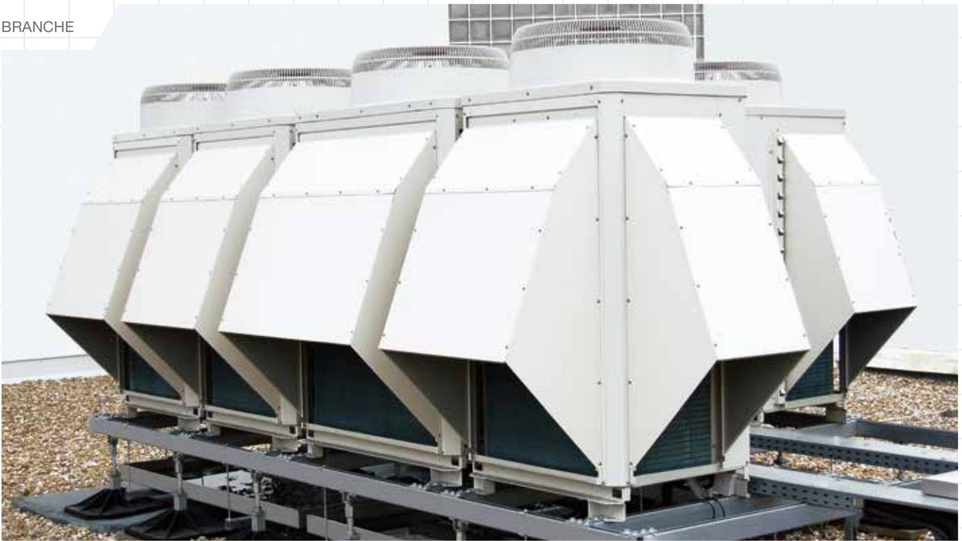
Eine windgeschützte Aufstellung oder optionale Schneeschutzhauben (Bild) sollten bei jeder Anlage berücksichtigt werden.
