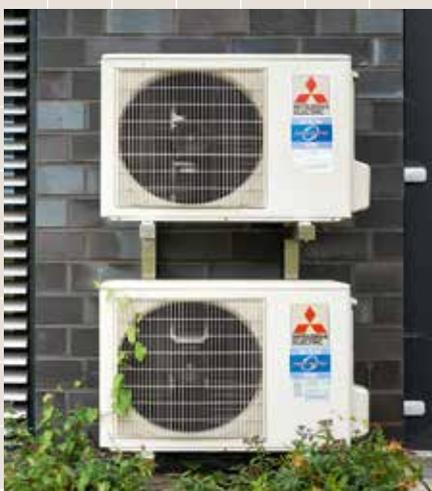
Aus Sicherheitsgründen sollten Klimaanlagen für Serverräume immer mit paralleler Leistungsreserve (redundant) ausgeführt werden.
