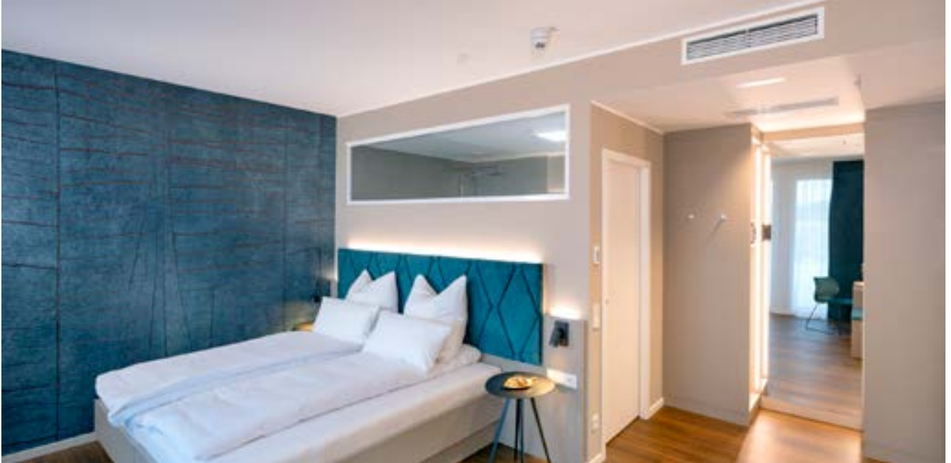
Für den Hotelbereich kommt mit dem Hybrid VRF-System von Mitsubishi Electric eine Klimatechnologie zum Einsatz, die die Umwelt schont und Behaglichkeit mit Komfort und Sicherheit verbindet.
