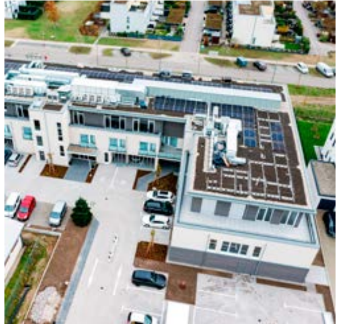
Das neue VEMA-Konferenzzentrum in Karlsruhe ist ein modernes und energieeffizientes Multifunktionsobjekt, bei dem besonders hohe Anforderungen an die Gebäudetechnik gelten.
