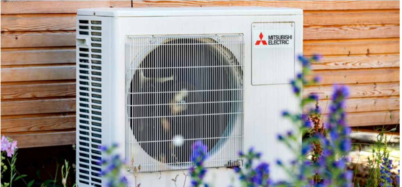
Jedes Ferienhaus verfügt über ein eigenes Außengerät mit einer Heizleistung von 7,0 kW und einer Kälteleistung von 5,4 kW.
