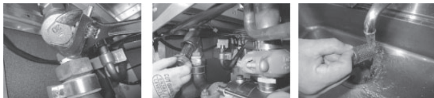
Manutenzione del filtro
