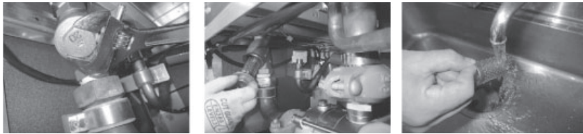
Maintenance de la crépine
