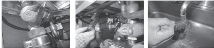
Mantenimiento del colador
