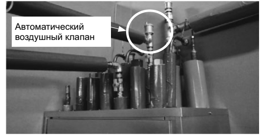
Рис. 1. Автоматический воздушный клапан
