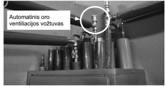
1 pav. Automatinis oro ventilacijos vožtuvas
