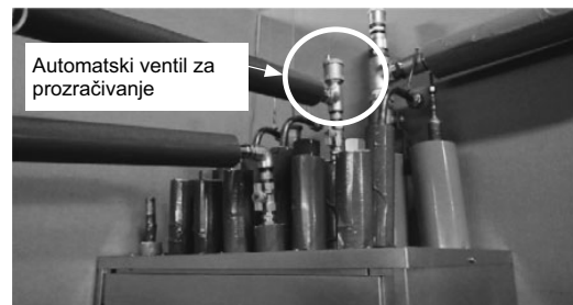
Slika 1. Automatski ventil za prozračivanje
