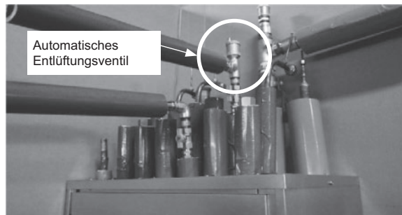
Abbildung 1 Automatisches Entlüftungsventil
