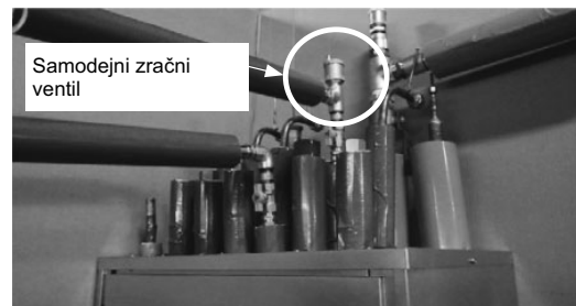
Slika 1. Samodejni zračni ventil
