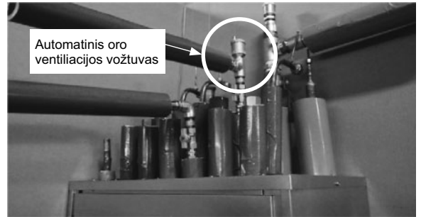
1 pav. Automatinis oro ventilacijos vožtuvas
