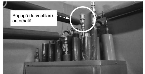
Figura 1. Supapă de ventilare automată
