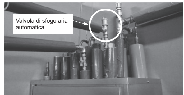
Figura 1. Valvola di sfogo aria automatica
