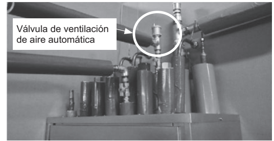
Figura 1. Válvula de ventilación de aire automática
