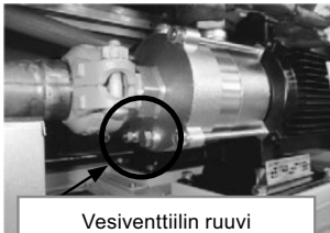
Vesiventtiilin ruuvi (Enintään kaksi kierrosta)
