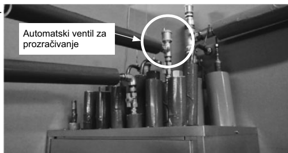
Slika 1. Automatski ventil za prozračivanje
