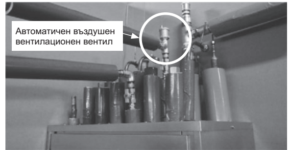
Фигура 1. Автоматичен въздушен вентилационен вентил
