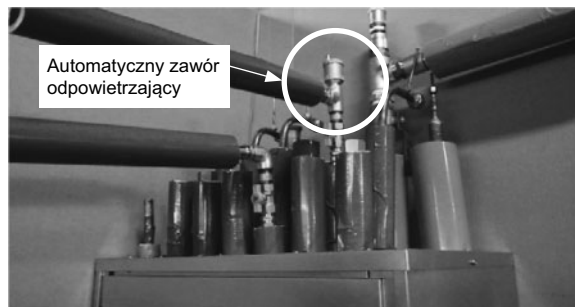
Rysunek 1 Automatyczny zawór odpowietrzający
