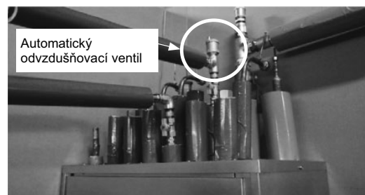
Obrázku 1. Automatický odvzdušňovací ventil
