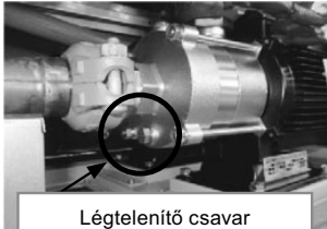
Légtelenítő csavar (Maximálisan két fordulat)
