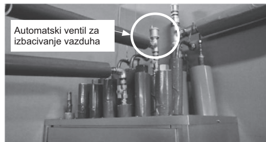
Slika 1. Automatski ventil za izbacivanje vazduha
