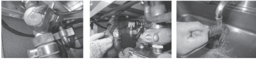
Manutenção do filtro
