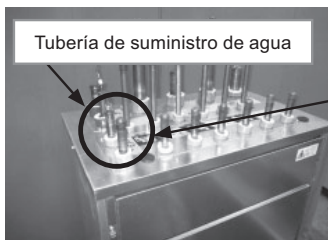
Conexión de la tubería de suministro de agua
