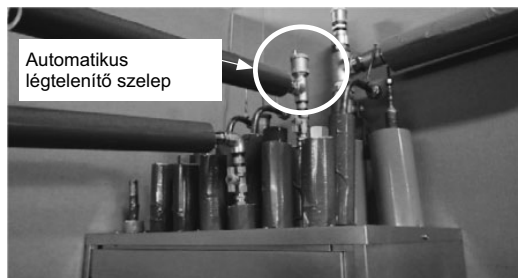
1. Ábra Automatikus légtelenítő szelep
