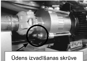
Ūdens izvadīšanas skrūve (ne vairāk kā divi pagriezieni)
