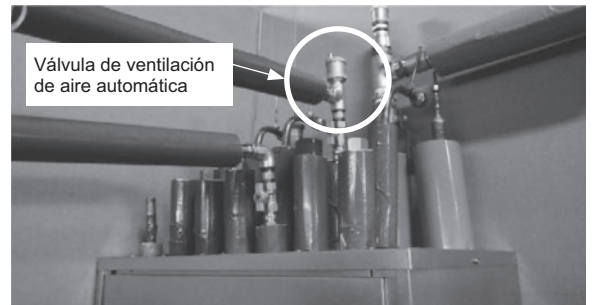
Figura 1. Válvula de ventilación de aire automática
