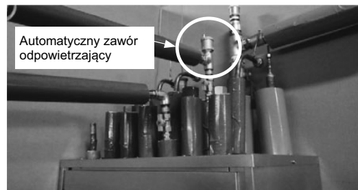
Rysunek 1. Automatyczny zawór odpowietrzający
