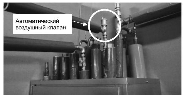
Рис. 1. Автоматический воздушный клапан
